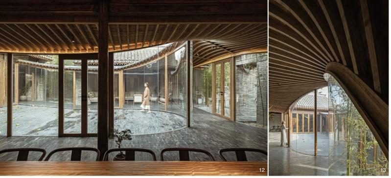
12. 遊廊延續屋頂的曲面線條,結合前後院景觀進行相應的起伏。13. 遊廊採用框架結構支撐密肋梁與板,讓新結構通透輕盈地融入到舊建築裡。14. 剖面圖。 15.16. 客廳區因透明遊廊與庭園彼此借景。
